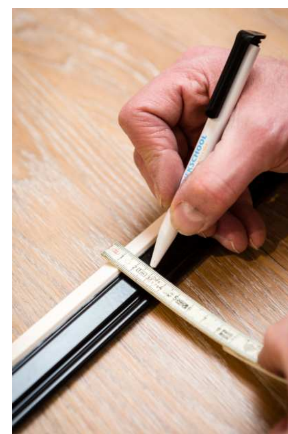
rys. 1.9: Oznacz pozycję do przecięcia/piłowania dla środkowego uchwytu
