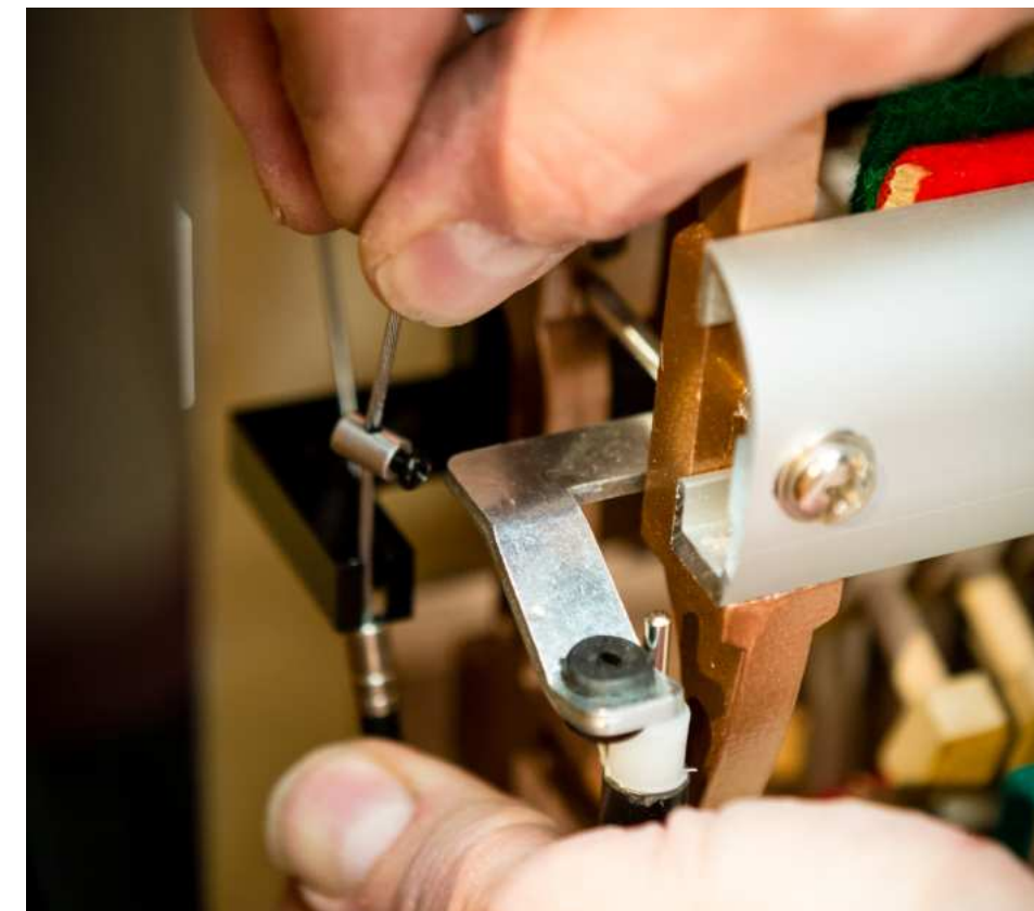
Abb. 1.21: Zugende in den Zughalter Einsetzen
