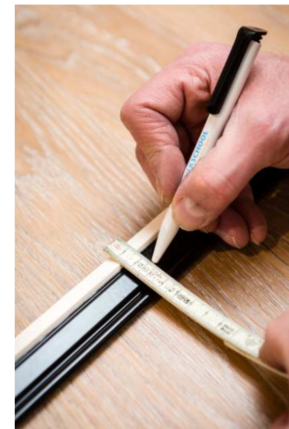
図1.9: 中間ブラケットの切断/のこぎりの位置をマークする。
