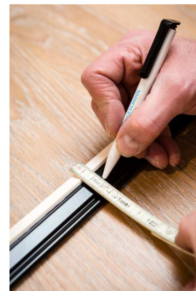
fig. 1.9: Marcar la posición de corte/ aserrado para el soporte intermedio
