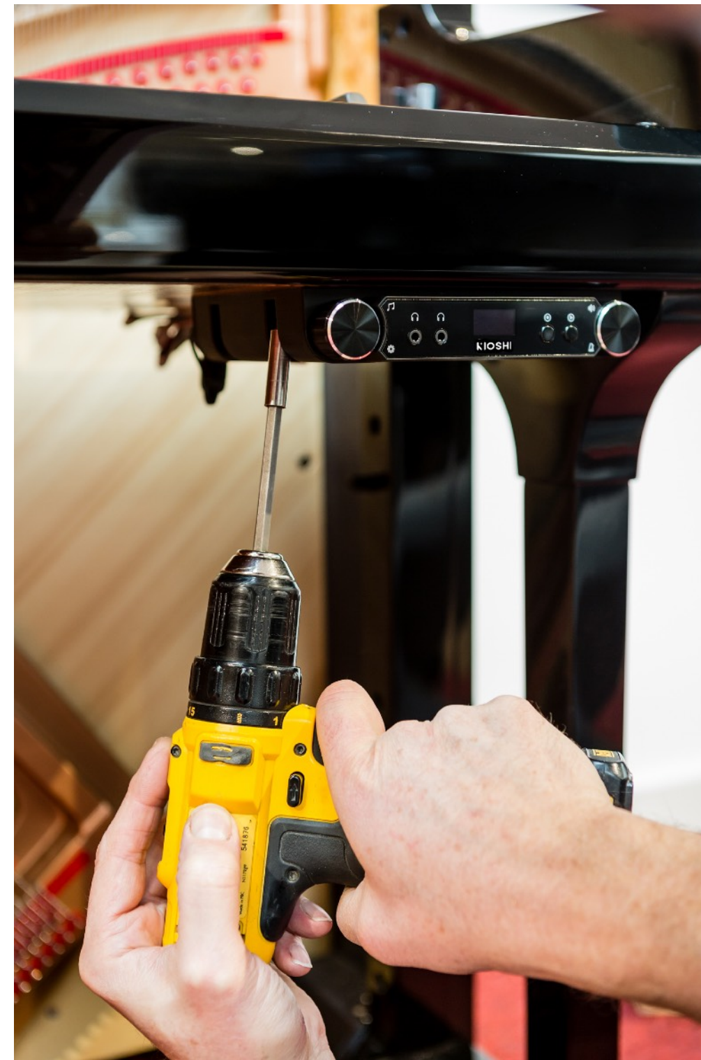
fig. 3.2: Meet de positie voor de bevestiging van de besturingsunit.
