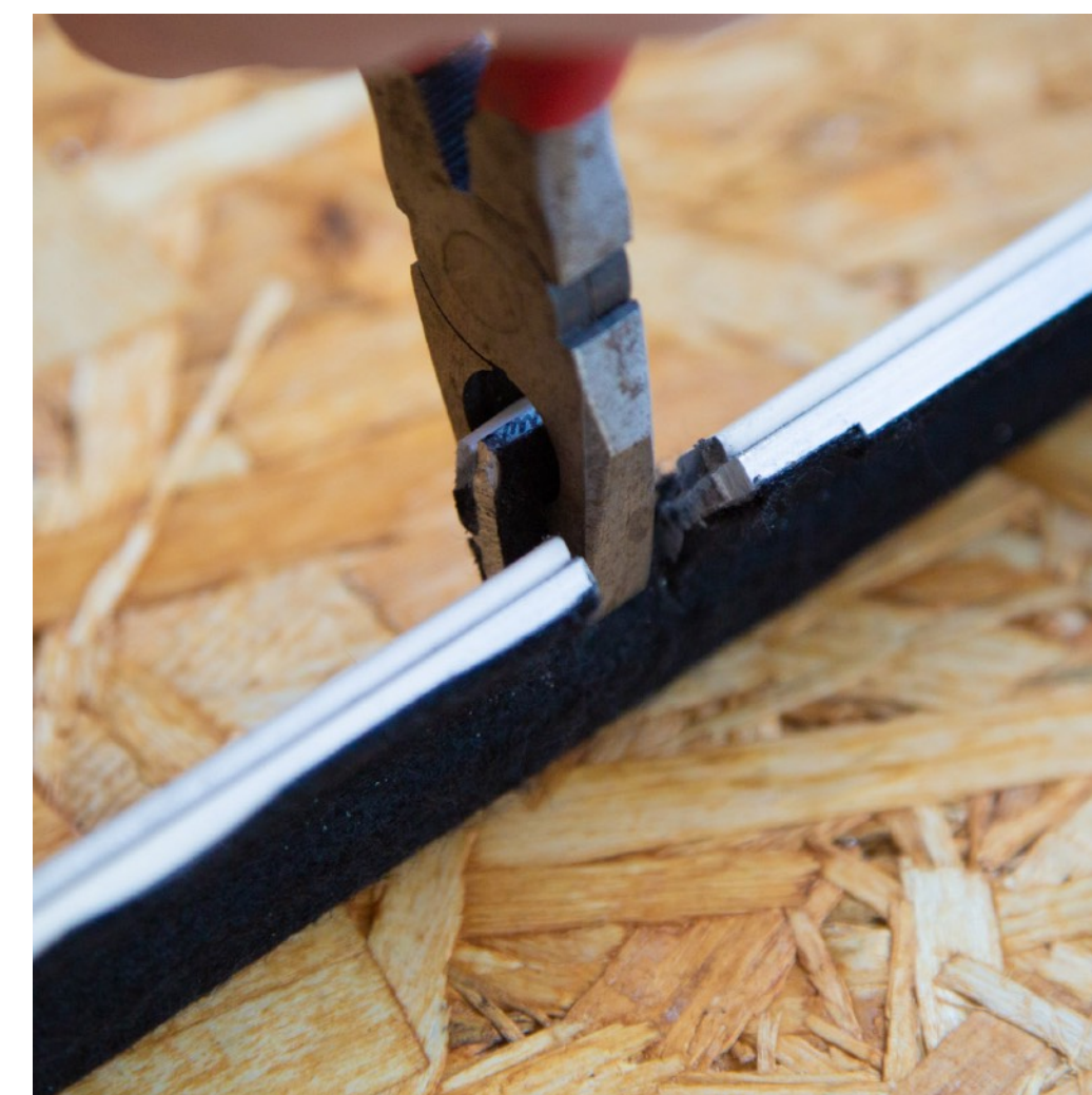
fig. 1.12: Verwijder het stuk metaal met een combinatietang.
