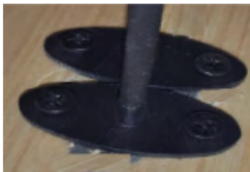
fig. 2.11: montagerbeugels
