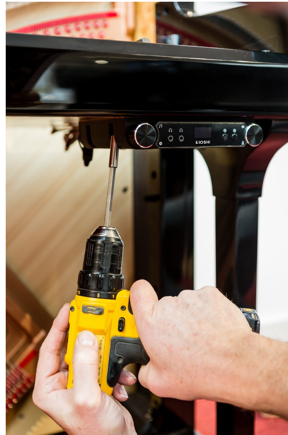
fig. 3.2 : Position pour l'installation du boîtier de commande
