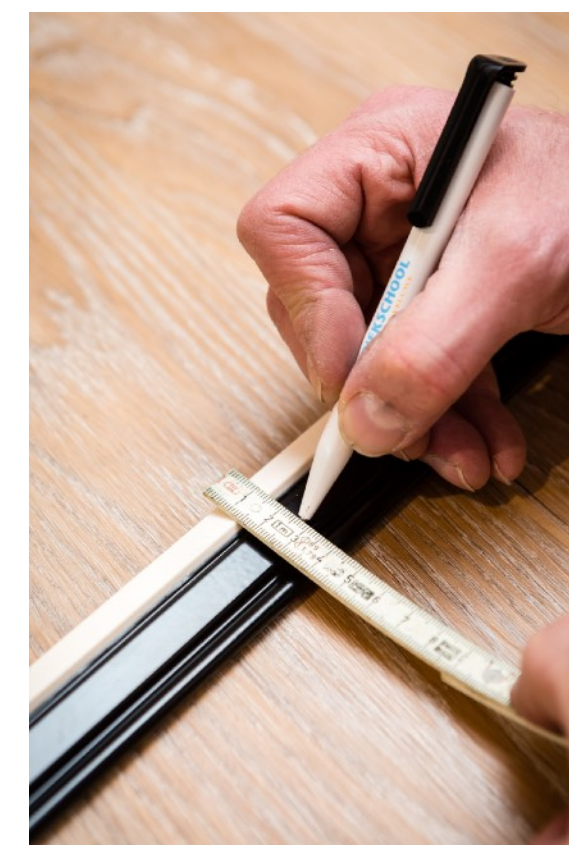
fig. 1.9 : Marquer les traits de coupe au niveau du montant de mécanique central
