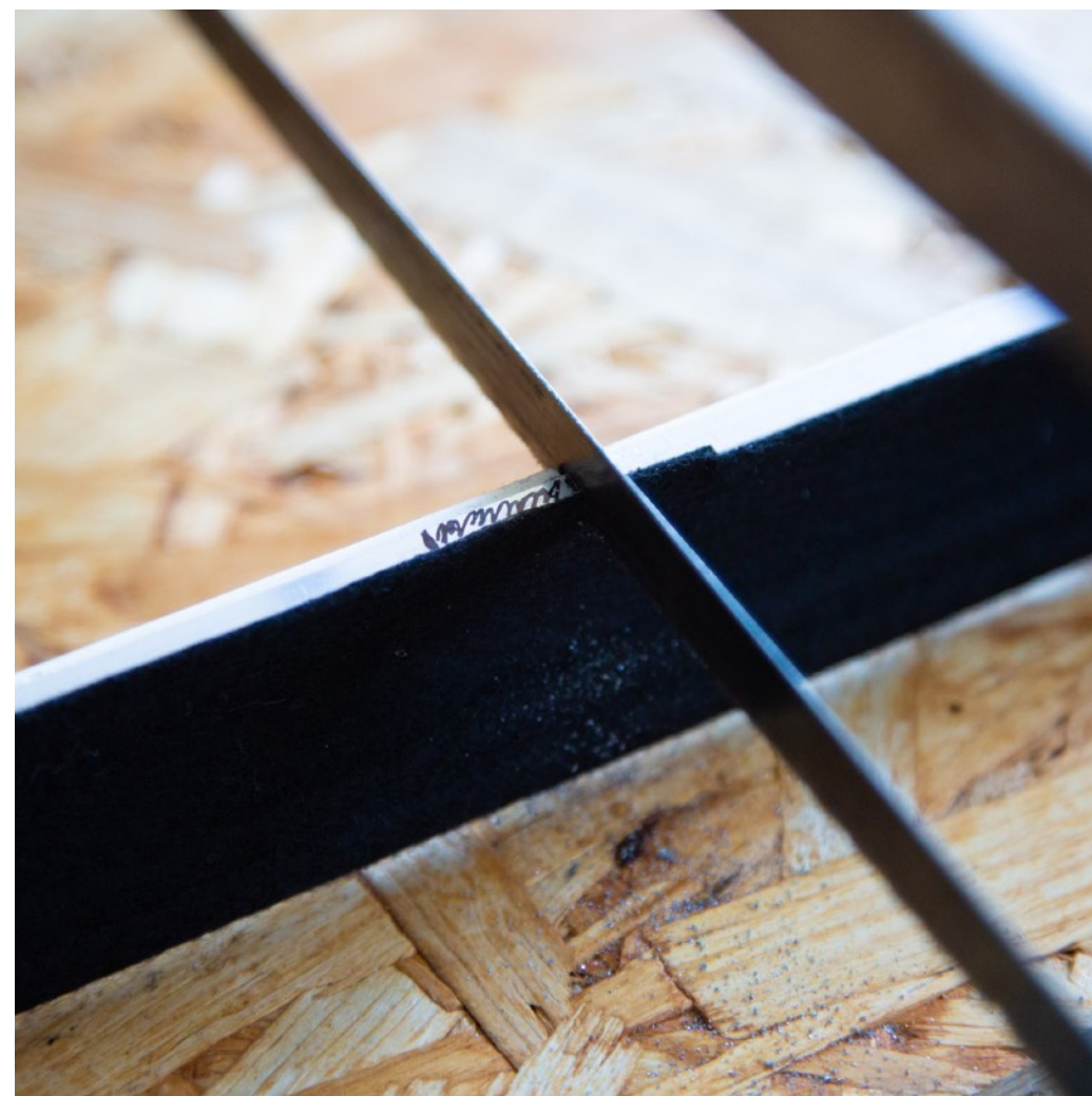
fig.1.10 : Couper la barre selon les repères effectués dans la mécanique
